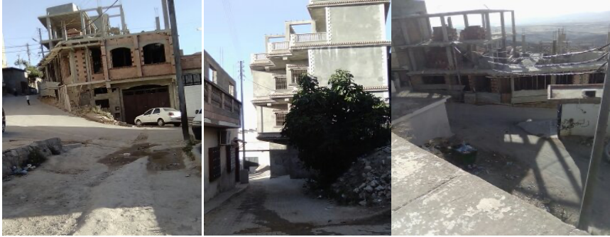
الصور تظهر التوجه الرأسي في البناء: إعداد الباحث
