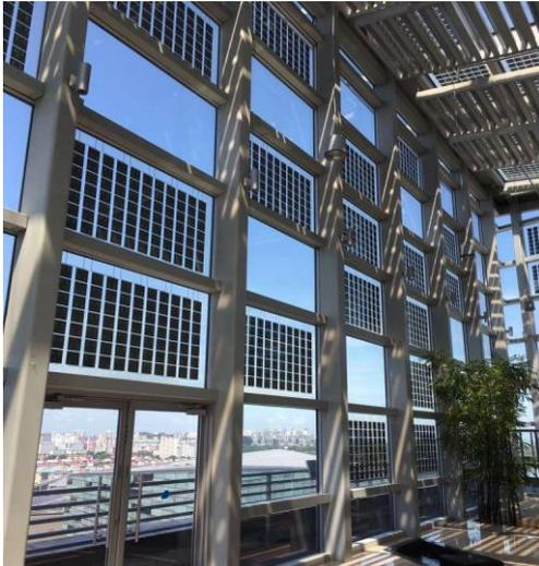
والتي تنتج الكهرباء مباشرة من ضوء الشمس، كما أمكن دمجها مع النوافذ الزجاجية نصف الشفافة والتي تمد المكان بالضوء المرشح أثناء توليدها للكهرباء"<sup>(4)</sup>. مثال (شكل 10) حيث تم دمج الخلايا الكهروضوئية بالنوافذ الزجاجية لتوفير الضوء الطبيعي للفراغات الداخلية.
