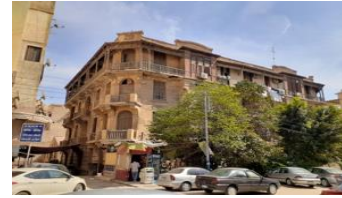
شكل (٣) أحد المباني بشارع المختلط المصدر: الباحث
