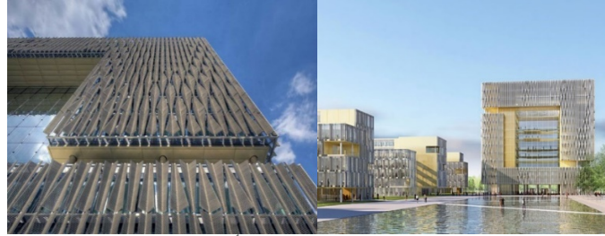
شكل (١٠): مبنى Q1 الألماني
