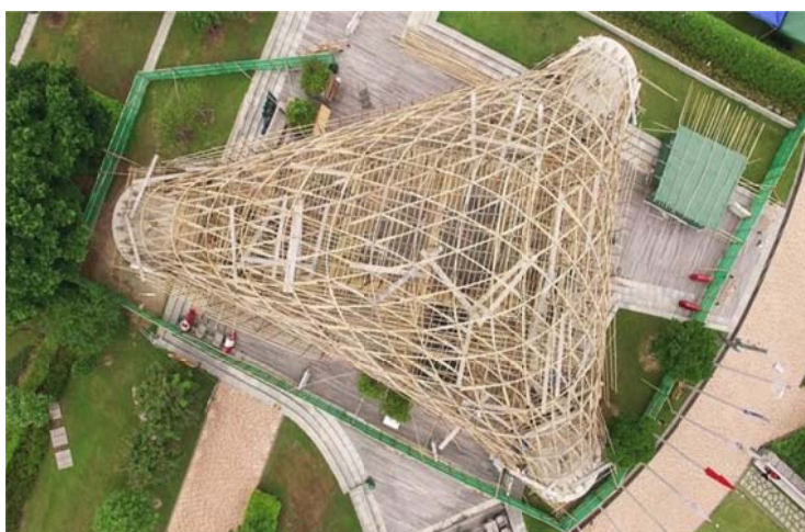
شكل (١١) تم بناء ZCB Bamboo Pavilion الذي تبلغ مساحته ٣٥٠ مترًا مربعًا تقريبًا باستخدام تقنيات السقالات المصنوعة من الخيزران الكانتونني وصنعت من ٤٧٥ عمودًا كبيرًا
