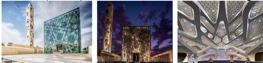
شكل رقم (7) يوضح مناظر خارجية وداخلية لمسجد مركز الملك عبد الله للدراسات والبحوث البترولية- الرياض - المملكة العربية السعودية (2009- 2016) - أحد أعمال زها حديد
