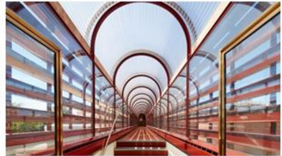
الجسر الذى يؤدي من المبنى الإدارى لشركة SC Johnson إلى البرج البحثى [٤٠]
