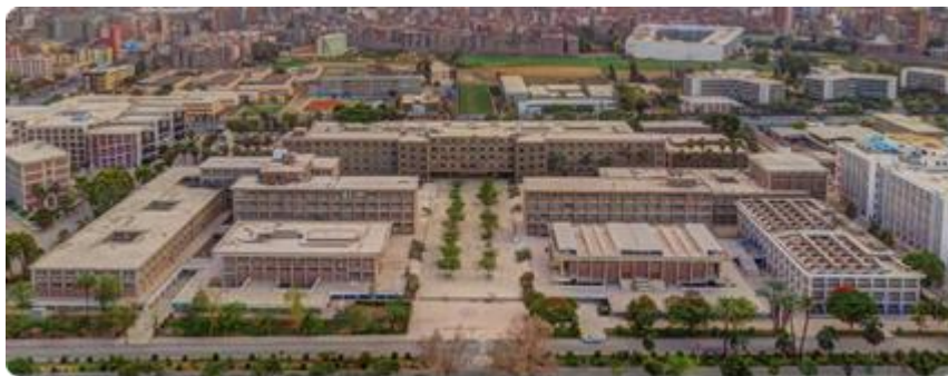
واجهات مباني كلية الهندسة [٢١]
