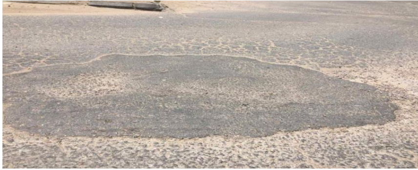
الشكل (7) شكل الترقيع بقطاع الطريق المدروس.
