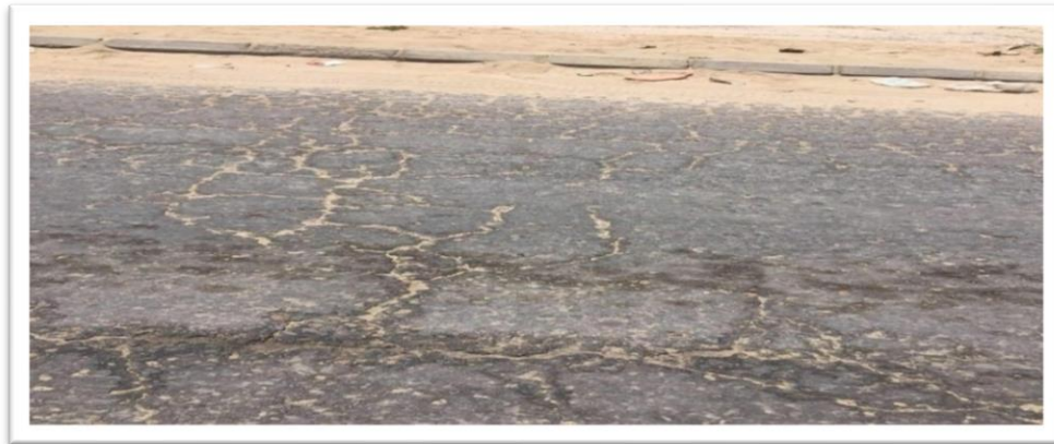
شكل (3) التشققات التماسحية بقطاع الطريق المدروس.
