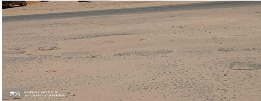
الشكل (5) الحفر الموجودة في مسار الطريق.
