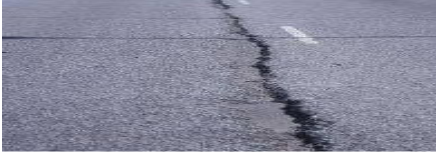
الشكل (4) التشققات الطولية بقطاع الطريق المدروس.
