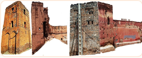
جانب من أبراج الجهة الجنوبية للقصة جانب من الواجهة الشرقية للقصة
