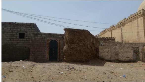
لوحة (14) أعمال البناء بالخرسانة والبلك على أنقاض المباني التاريخية
