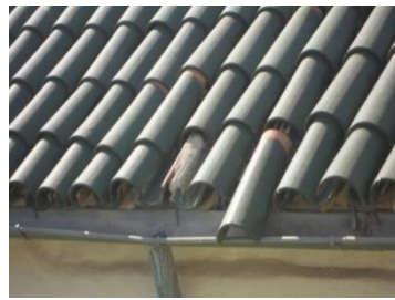
(أ) صيانة و تنظيف أنابيب صرف مياه الأمطار بسقف المتحف
