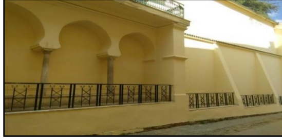
صورة 19: إعادة دهان الواجهة الرئيسية للقصر
