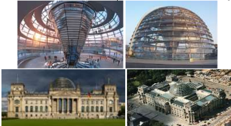
شكل (7) قبة مبنى البرلمان في برلين- ارتباط الفراغ الداخلي بالبيئة الخارجية بواسطة الطاقة الشمسية للتدفئة باستخدام الزجاج كفاصل مادي بين البيئة الداخلية والخارجية
