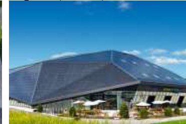
شكل (3) يوضح مبنى Umwelt Arena ذو السقف البلوري من وحدات PV
