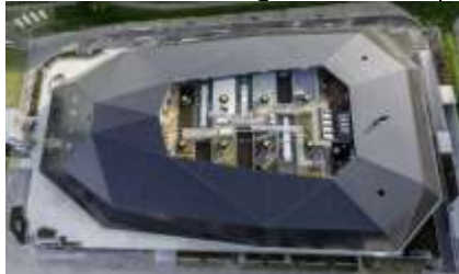
شكل (3) يوضح مبنى Umwelt Arena ذو السقف البلوري من وحدات PV
