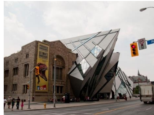
الشكل(16) مبنى متحف أونتاريو بكندا.
