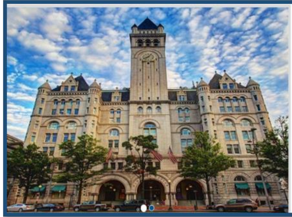
شكل رقم ( 14 ) مبنى مكتب البريد القديم بواشنطن
