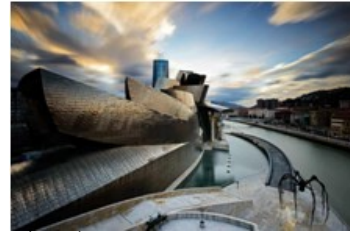
الشكل رقم ٩- يوضح الشكل المواد المستخدمة لتغطية متحف Guggenheim الزجاج للرددة، والحجر الجيري، والتيتانيوم كمادة تغطي معظم كتلة المتحف، وتعكس تألق الطقس المحيط. يوضح الشكل أيضاً الممر المنحني والمعالم المائية المحيطة بالمبنى. المصدر: https://www.pdfprof.com/
