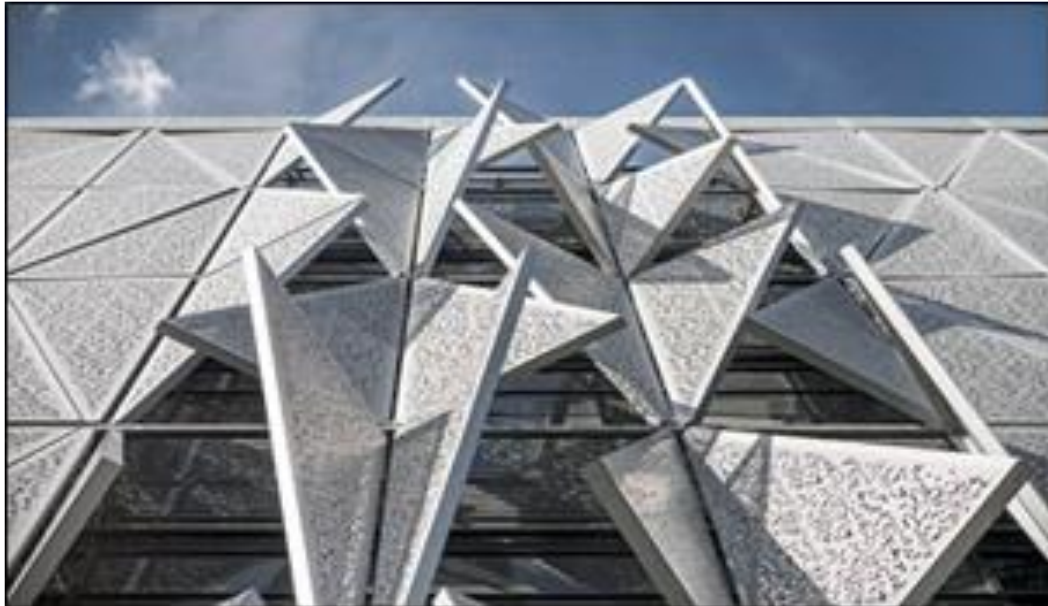
شكل ١٧: واجهة مبنى (university building in Kolding, Denmark) توضح استجابة الواجهة للمتغيرات الخارجية من خلال اغلاق المثلثات بنصف مفتوح او مفتوح بشكل كامل او مغلق بشكل كامل للتحكم بكمية الإضاءة الداخلة للمبنى [٣٢].
