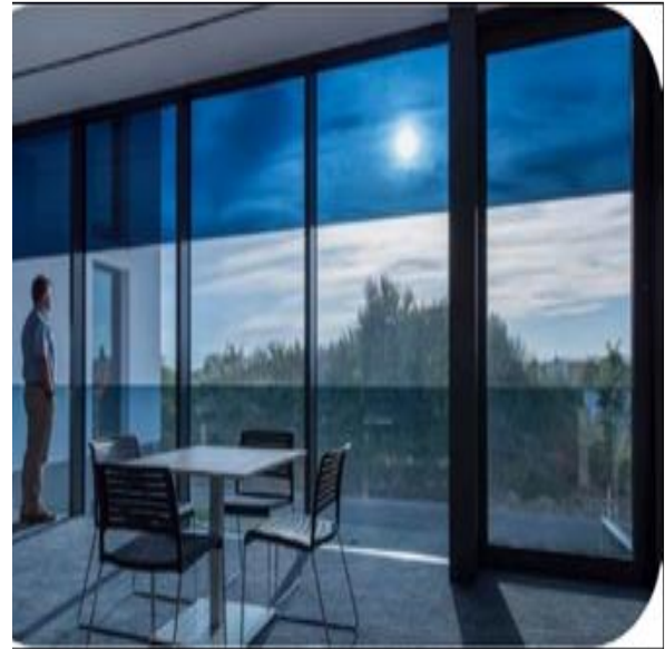
شكل ٧: يوضح تغير درجة الشفافية للزجاج الخارجي بواجهة بناء على شدة الإشعاع الشمسي [١٩].
