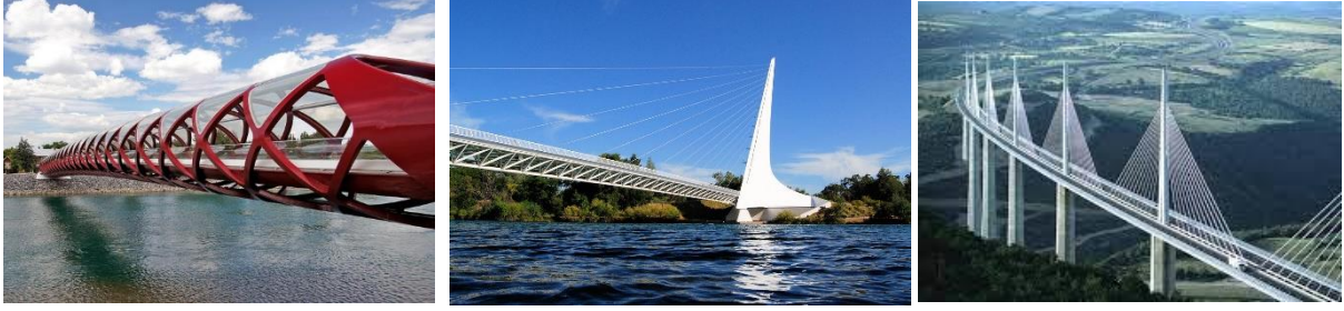
شكل (2) كوبري ميلو للمعماري نورمن فوستر شكل (3) كوبري الاميلو و كوبري كالجاري للمعماري سانتياغو كالاترافا
