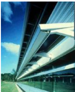
شكل (١٢): دمج الخلايا الفوتوفولتية مع كاسرات الشمس المائلة في مبنى مركز الأبحاث في جامعة نيويورك [13].
