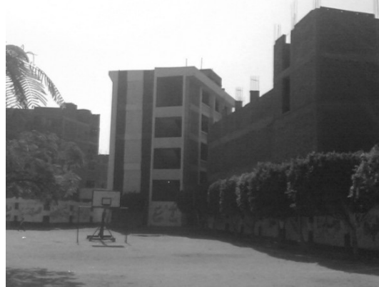
شكل رقم ٧ - يوضح الفناء لمدرسة صفية زغول للتعليم الاساسي المصدر : - الهيئة العامة للابنية التعليمية - ٢٠١٧
