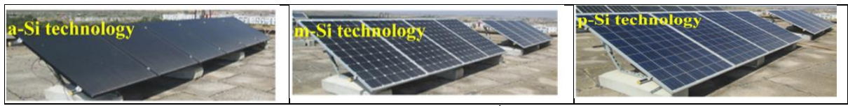
الشكل 7: صورة لأنواع الثلاثة من تقنيات الخلايا الشمسية [90]
