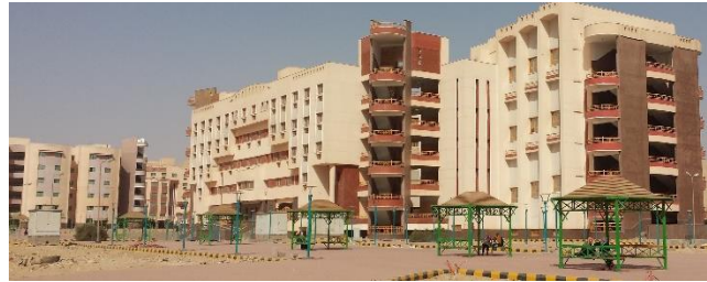
صورة فوتوغرافية للواجهة الجنوبية الخاصة بكلية الآداب
