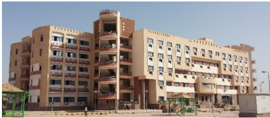
صورة فوتوغرافية للواجهة الجنوبية الخاصة بكلية التربية
