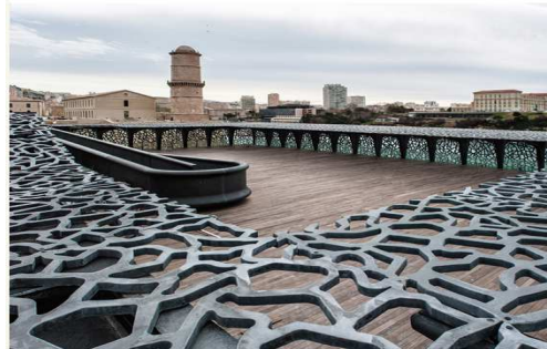
شكل (١٥) يوضح شكل سقف المتحف الشبيه بفروع الأشجار في تكرار خطوطه المتعرجة ، شكل (١٦) يوضح الهيكل الداخلي المصنوع من الصلب والزجاج ، والأعمدة الخرسانية الحاملة للمبنى ،
