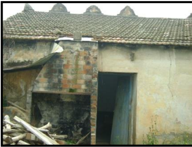
الصورة رقم 14: السقف المائل لإحدى غرف الحصن
