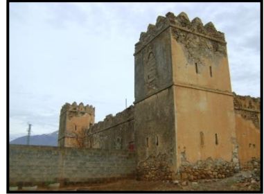
الصورة رقم 03: إحدى مراكز المراقبة بالحصن
