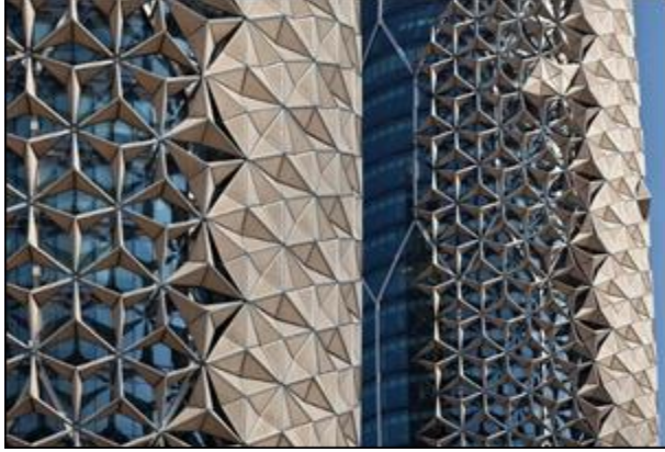
شكل ٦: يوضح استجابة وحدات لتظليل بواجهات مباني أبراج البحر لحركة الشمس فعند سقوط أشعة الشمس عليها تغلق لتحجب أشعة الشمس المباشرة، وعند عدم تعرضها لأشعة الشمس المباشرة فإنها تنطوي لتسمح بدخول الضوء الخارجي الى داخل فراغات المبنى [١٧].
