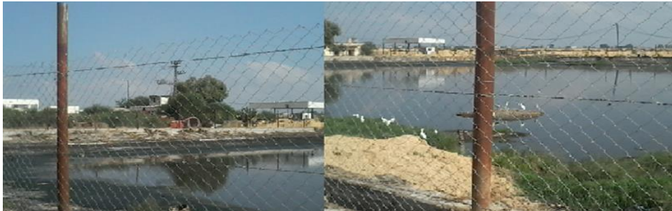
شكل (٣،١٢): البرك الترابية في محطة الشمال للمعالجة . المصدر: "إعداد الباحث"
