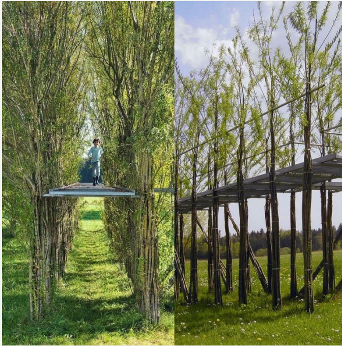
صورة (١٠) "جسر المشاة Baubotanical" على موقع مشروع "Neue Kunst am Ried".
