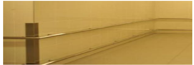
شكل (4-1) يوضح طريقة تركيب مصدات رأسية عند تلاقي الحوائط واستخدام القضبان الداعمة في الطرقات ، في الشكل المقابل تم استخدام الفولاذ المقاوم للصدأ حيث يمتاز بمنع انتقال البكتريا وسهولة التنظيف ومنخفض الصيانة مع صيانة طويلة العمر
