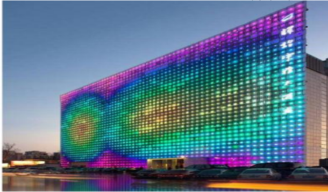
شكل (9-1) واجهة مبنى Greenpax التي تضيء في المساء بألوان مختلفة Pasternack, 2008
